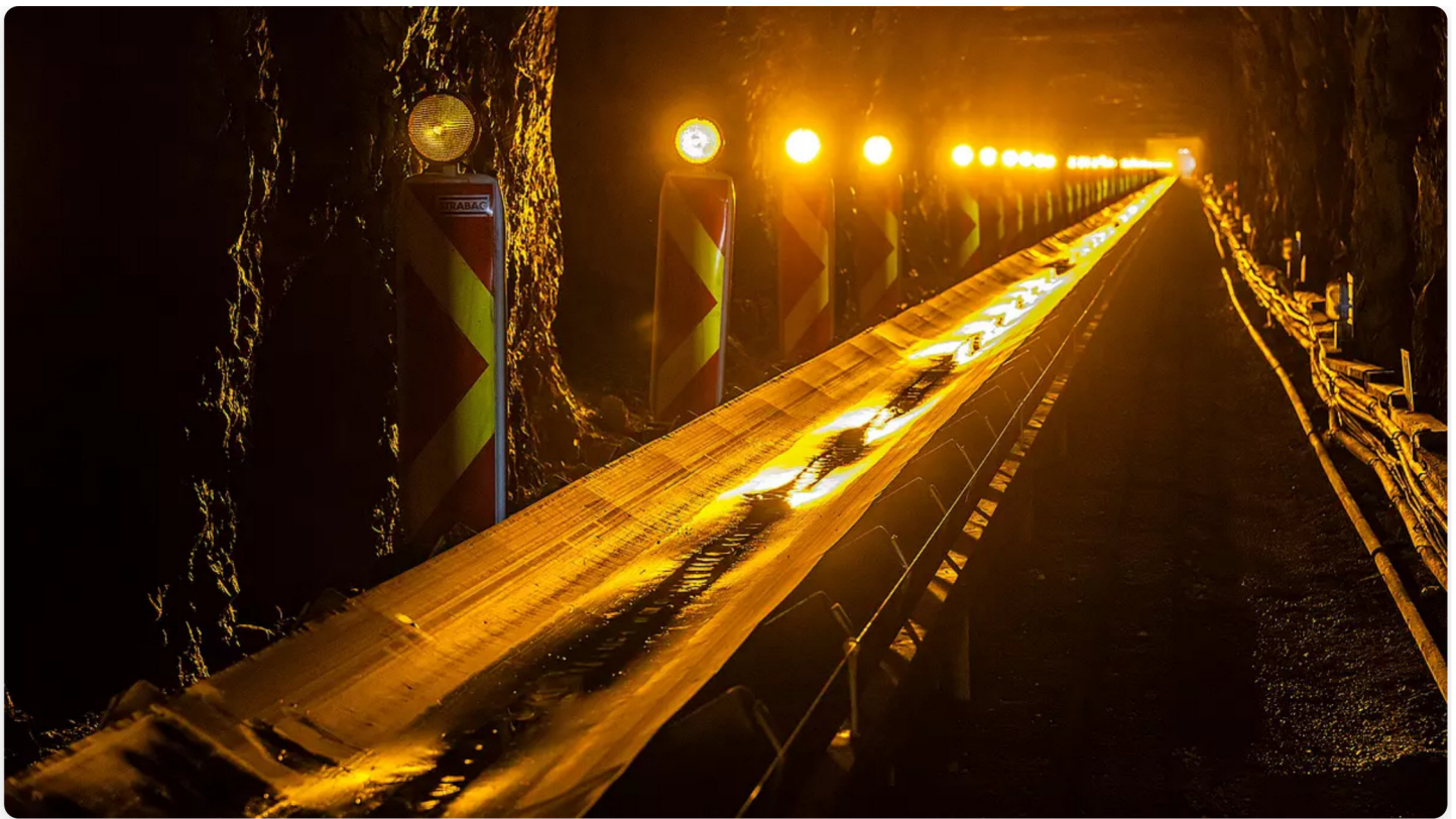
"Alpenglühén Karbach": Licht am Ende des Stollentunnels
